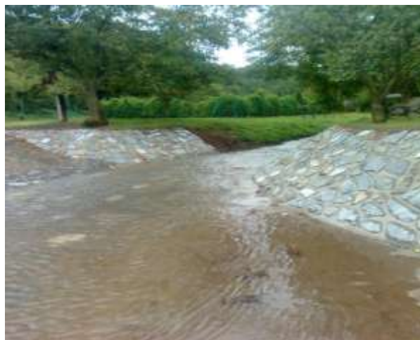
Brod po vybudování
